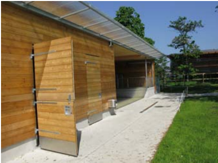
Bitte eintreten! Der neue Stall und die Anlage sind fertig!
